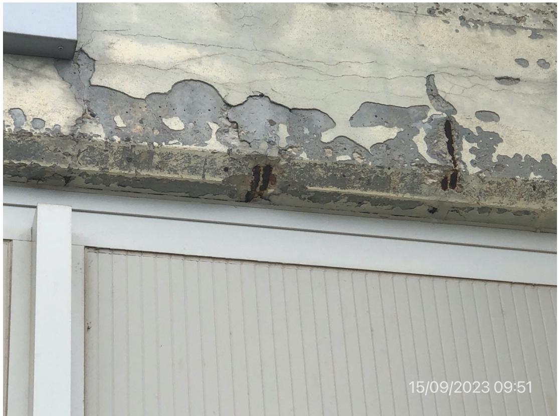
Foto 7: armature in vista
