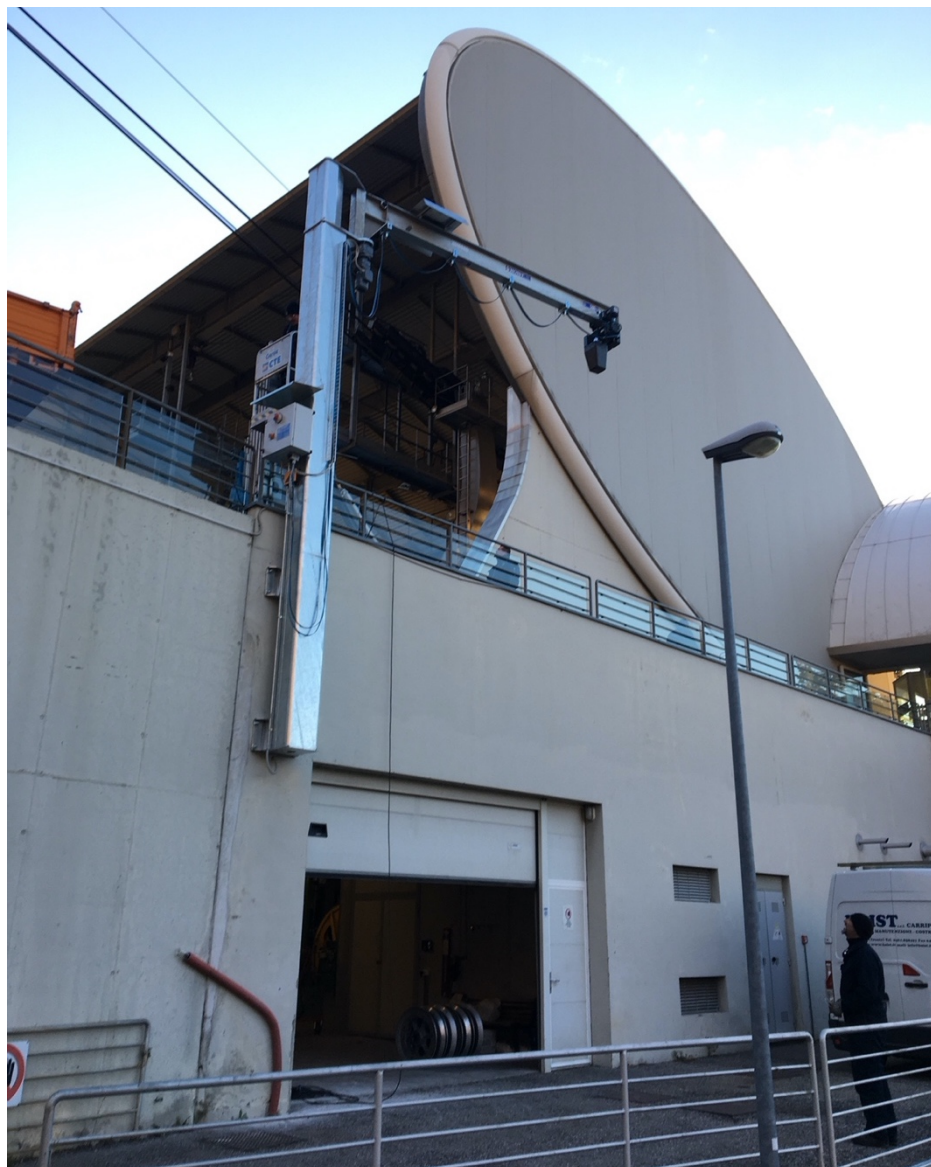
Foto 4: distacco tra le due murature che si è aggravato nel tempo
